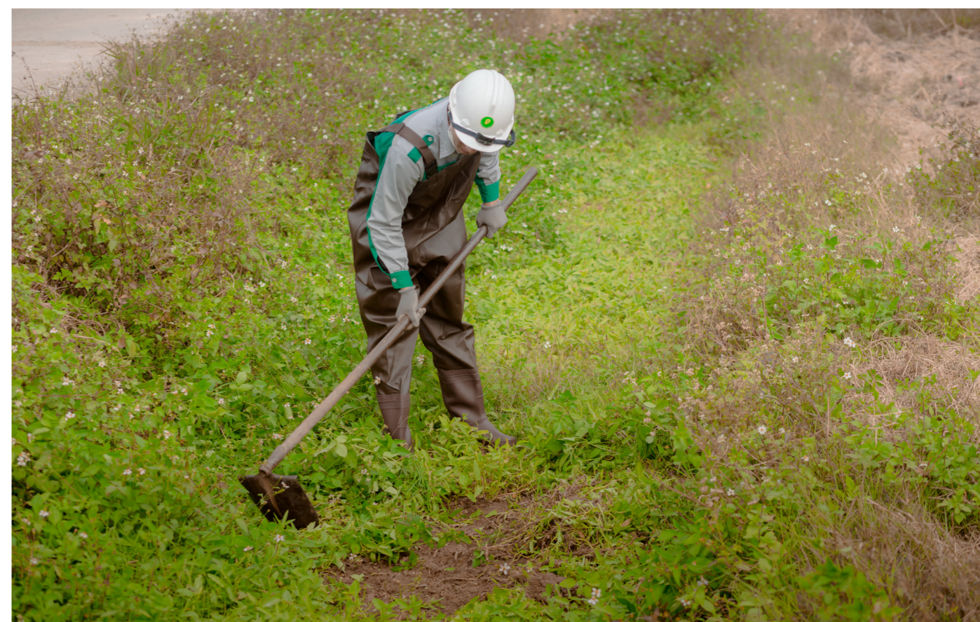
Công nhân nạo vét mương
