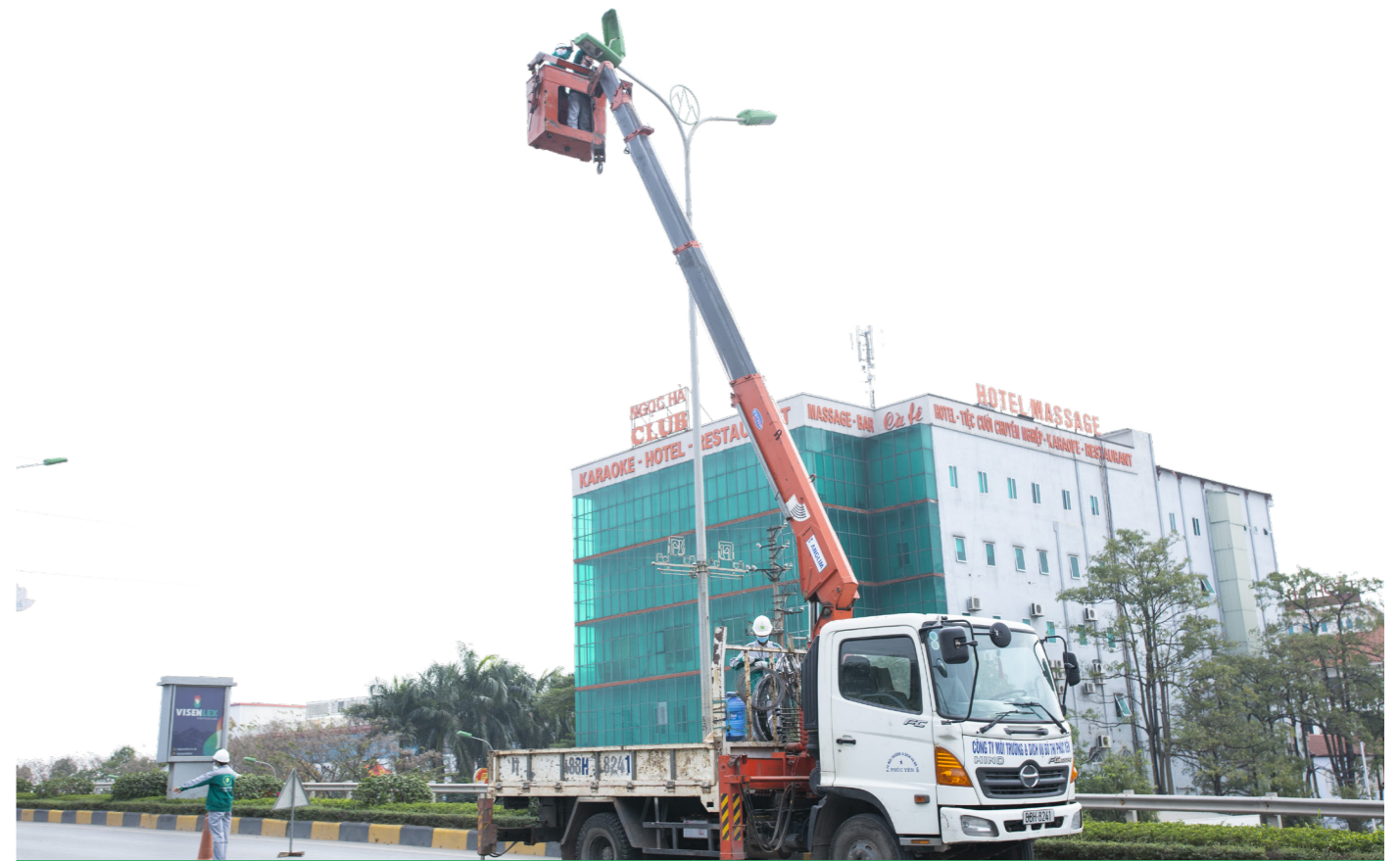
Sửa chữa điện đường phố trên cao
