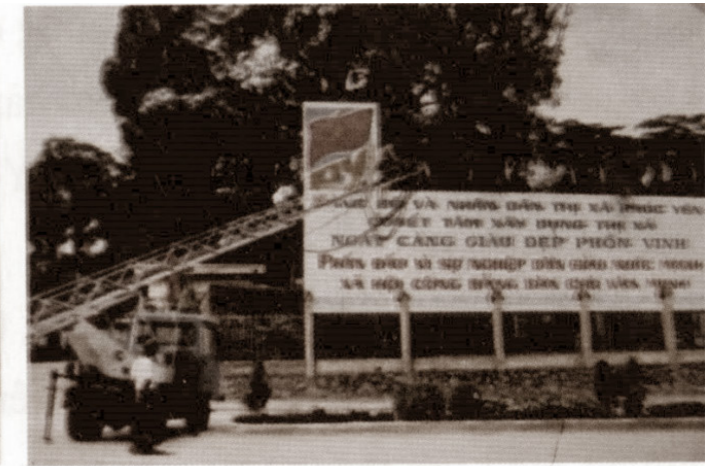
Sửa chữa điện bằng xe thang điện MULTICA
