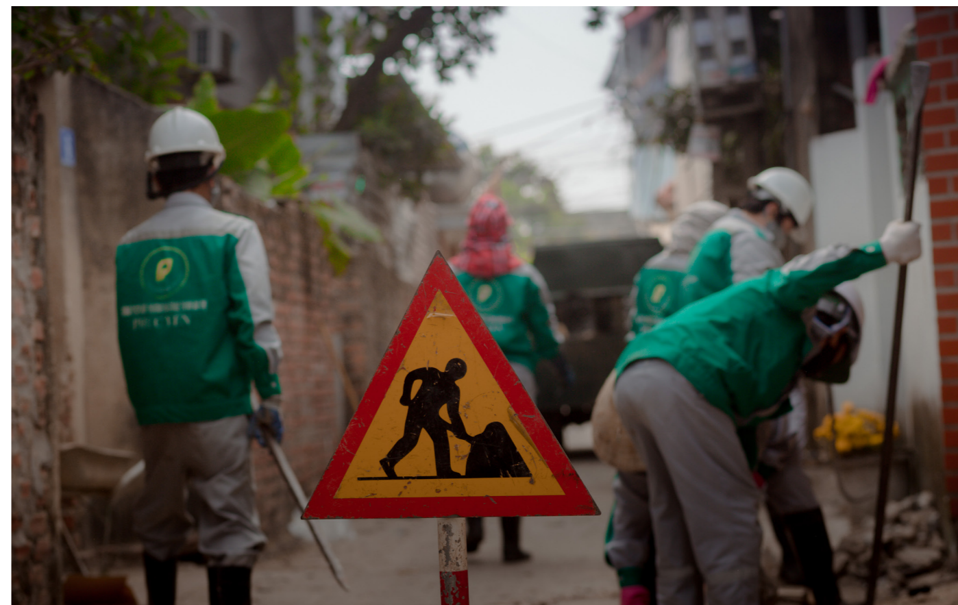
Công nhân nạo vét khơi thông cống rãnh
