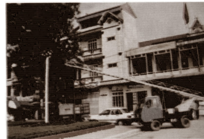
Sửa chữa điện bằng xe thang điện MULTICA
